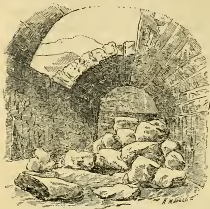
Le puits de Jacob. (État actuel.)
